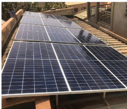
Installation d'un système solaire dans un ménage à Ouagadougou
