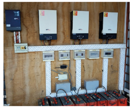
Mise en place d'un système de pompage d'eau pour client industriel à Ouagadougou
